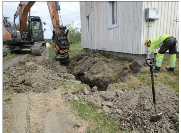
Vasen kuva: Kaapelilinja pellolla ennen kaivamisen aloittamista. Maantieojan leikkauksesta tiiltä lapion kohdalla. Länteen. Oikea kuva: Kaapeliojaa kaivetaan asuinrakennuksen vieressä. Pohjoiseen.
